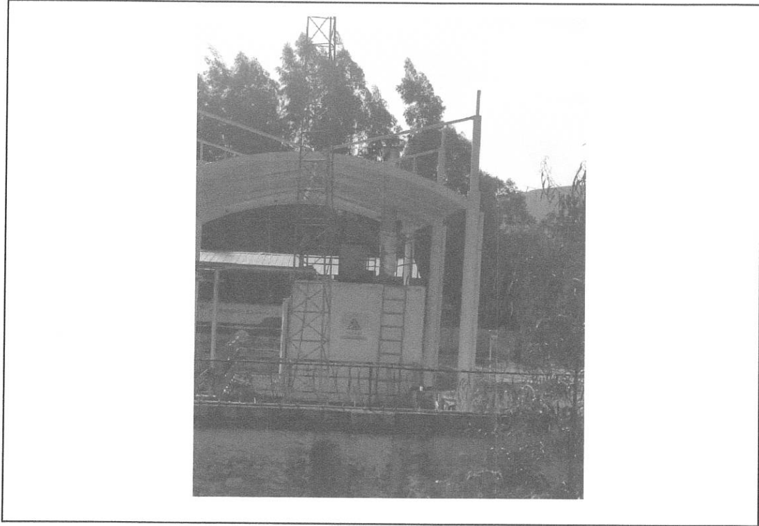
图 6-3 现场采样照片
